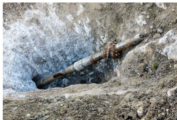
24.11.2016: Ankunft des Bohrgestänges in der Zielgrube auf dem ARA-Areal.
