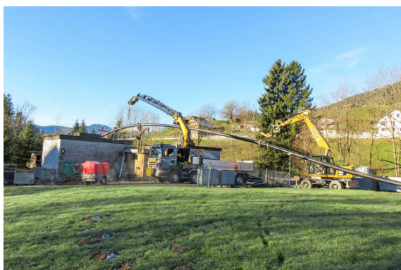
6.12.2016: Einzug des Kanalrohrs vom Brüggli her zum Ecce Homo (über die ARA).
