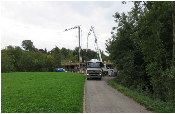
Flachdächer betonieren
