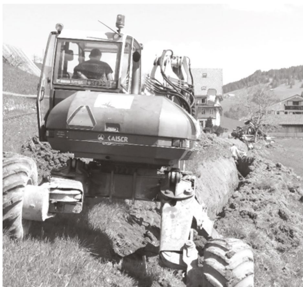
Am 11. April begannen die Grabarbeiten ab Lustnau.
